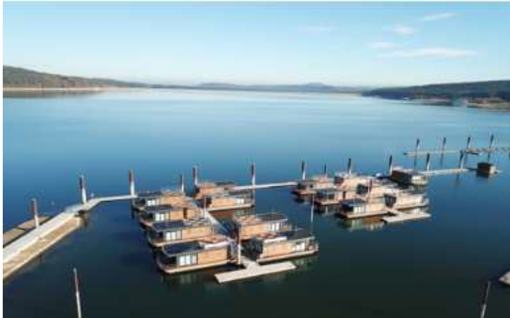
Ferienhausanlage Floating Village Brombachsee mit aktuell 15 Häusern.
